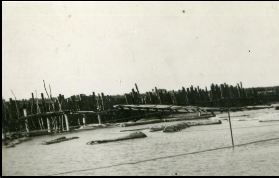
Foto 5. Tomrukların denize kaçmaması için Fabrika önlerinde Kızılırmak üzerine kurulan tahkimat.
