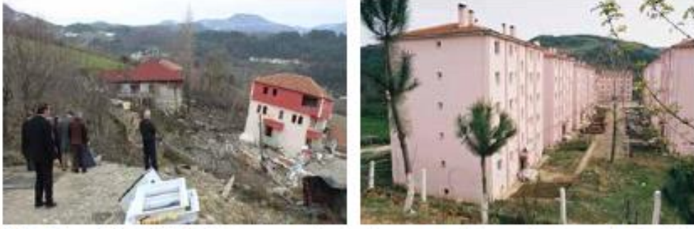
Foto 4. Sinop-Türkeli köylerinde yaşanan heyelanlar sonucu yıkılan meskenler ve bu tür felakete maruz kalan vatandaşlarımız için ilçe merkezine inşa edilmiş olan afet evleri.
