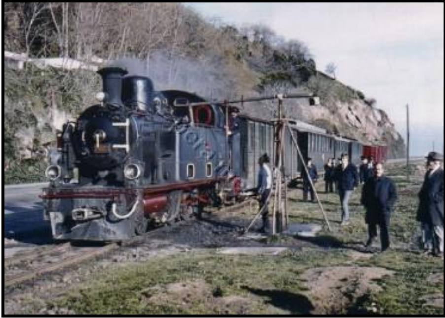
Derbent mevkii; tüneller kaldırılmış, karayolu demiryoluna paralel gider hale gelmiş (üstte). Aynı mevkide buharlı lokomotif su takviyesi yapıyor.
