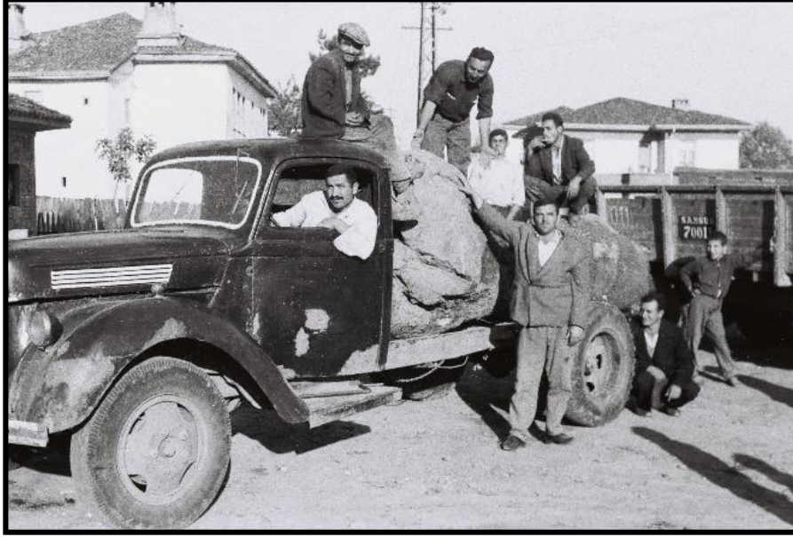
İnşaat zemininde kullanılan taşları taşıyan kamyon.
