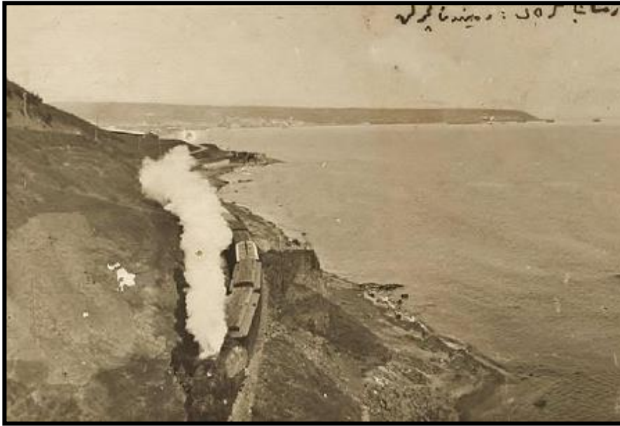
Tüneller kaldırıldıktan sonra Çarşamba demiryolunun Derbentten geçişi. Henüz karayolu yok. Karayolu daha yukarıdan geçiyor ve araç trafiğine çok uygun değil.
