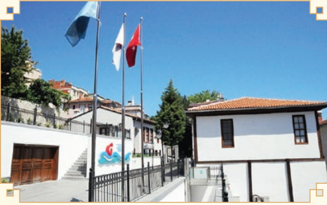
Foto 3. Sadi Tekkesi Külliyesi, avludan görünüm.
