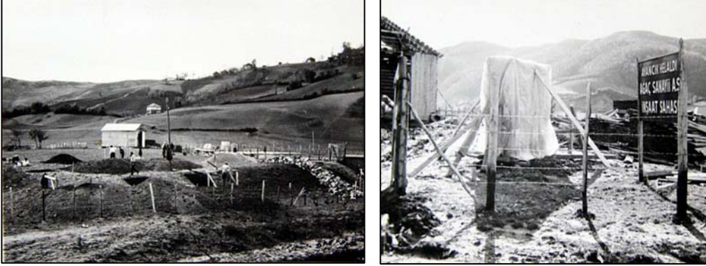
Foto 17-18: AYHEL Kereste fabrikası inşaat çalışmaları (Haşim Örnek Albümü).
