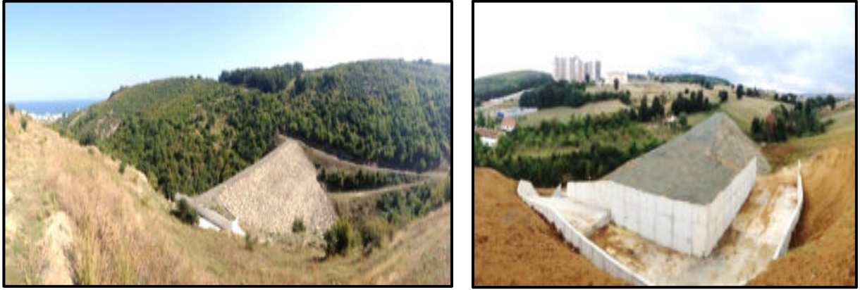
Foto 17-18. Atakum'da inşa edilen; solda Değirmendere, sağda Çobanlı sel kapanları.
