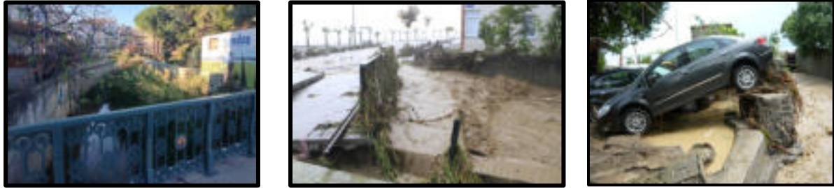
Foto 11-12-13. Değirmendere'nin kanal içine alınmış saikin hali ve 6 Ağustos 2012'de sel ve taşkın zamanı ve sonrasında ortaya çıkan görünüm (Samsun Büyükşehir Belediyesi Arşivi).
